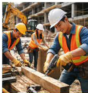
建築現場・作業場
